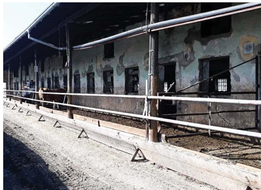
Foto 1. Původní stav „Šlechtitele“ v roce 2018 před rekonstrukcí - exteriér
