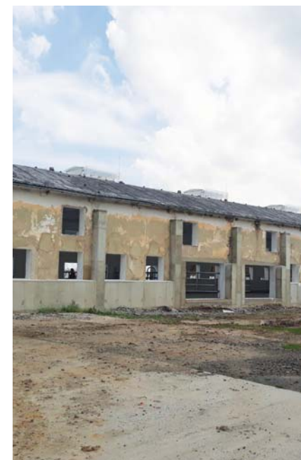
Foto 4. Ztužovací sloupky a střešní větrací světlíky
